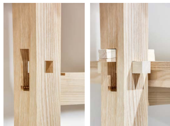
▲ Le système d'assemblage des étagères est inspiré des techniques traditionnelles japonaises.
