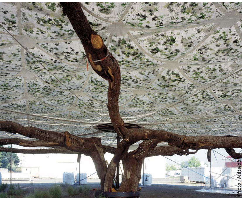
▲ Chapiteau itinérant sous forme d'arbre géant conçu pour les rencontres citoyennes à Nantes. Structure en chêne et couverture en PVC. Création : Tetrarc/Métalobil.
